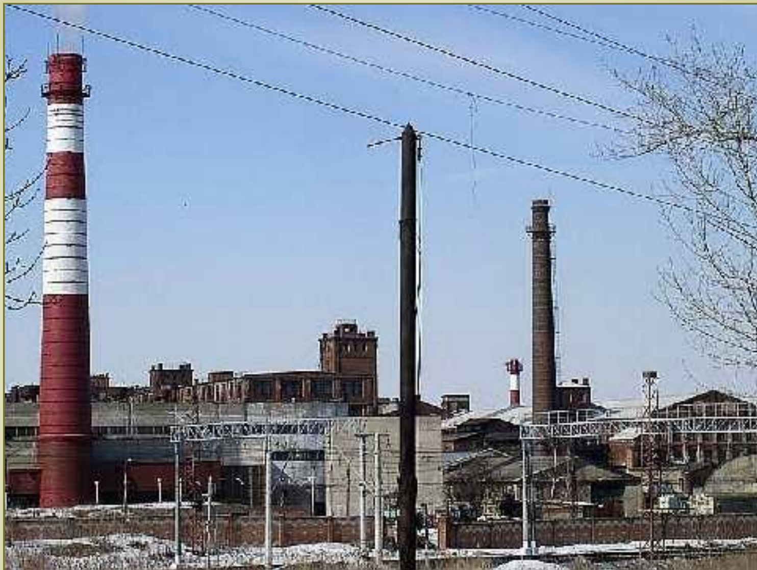
Подольск. Завод «Зингер».
