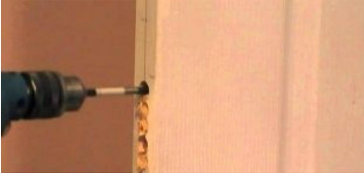
Начиная с верхней границы контура, просверлите несколько отверстий в торце, располагая их вплотную друг к другу. Дойдя до нижней границы нарисованного контура, отложите дрель и подровняйте стенки получившегося паза с помощью стамески и молотка. Действуйте очень аккуратно, чтобы не срубить лишнюю древесину. У вас должно получиться отверстие нужной глубины с ровными краями.
