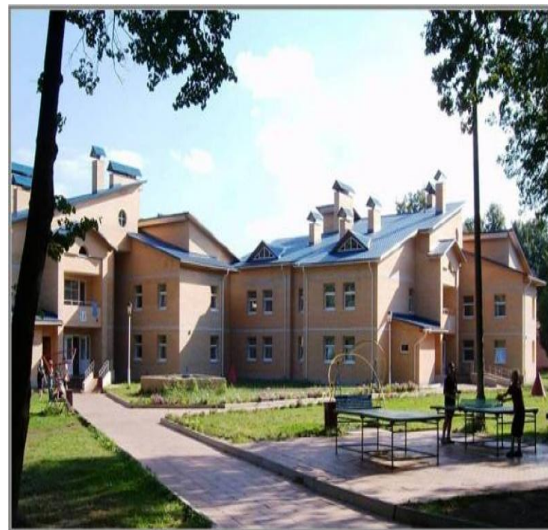
Новое строительство 2-х корпусов пионерского лагеря «Ракета»
