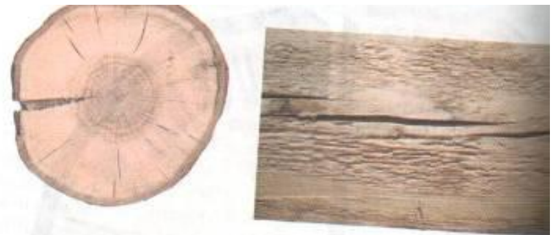
Рис. 12. Трещины древесины при несоблюдении правил сушки
