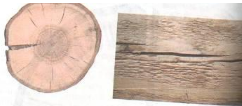
Рис. 12. Трещины древесины при несоблюдении правил сушки
