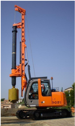
Буровая установка TES CAR CF3
