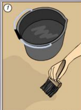
Смочить ДВП водой
