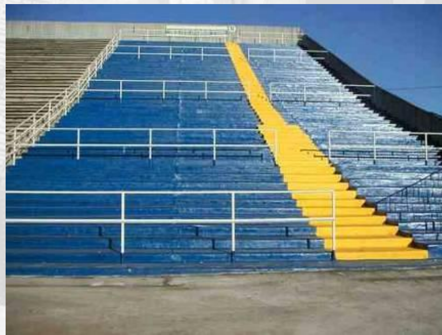
...после проведения работ
