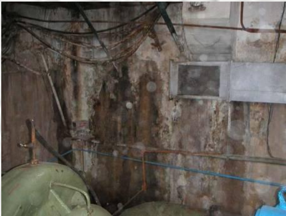
...до проведения работ
