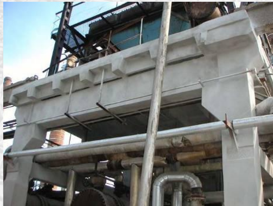
...после проведения работ
