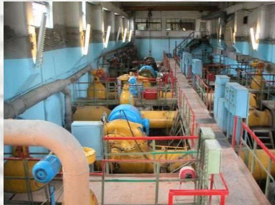
...после проведения работ
