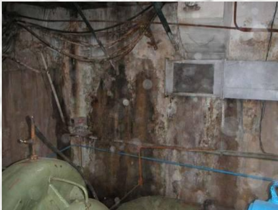
...до проведения работ
