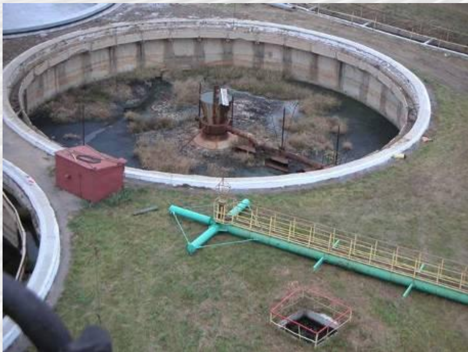
...до проведения работ
