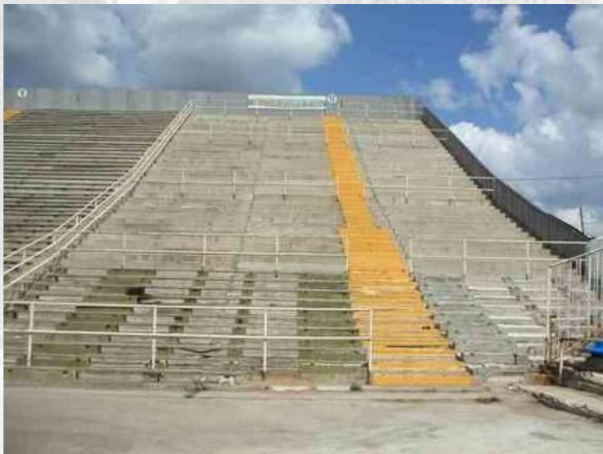
...до проведения работ
