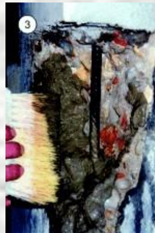
Нанесение грунтовочного слоя ремонтного материала САМКРИТ 10 или САМКРИТ 40
