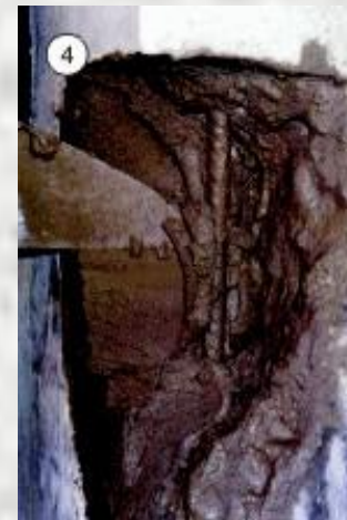
Ремонт бетона САМКРИТ 10 или САМКРИТ 40
