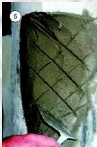
Подготовка под основания под восстановление бетона
