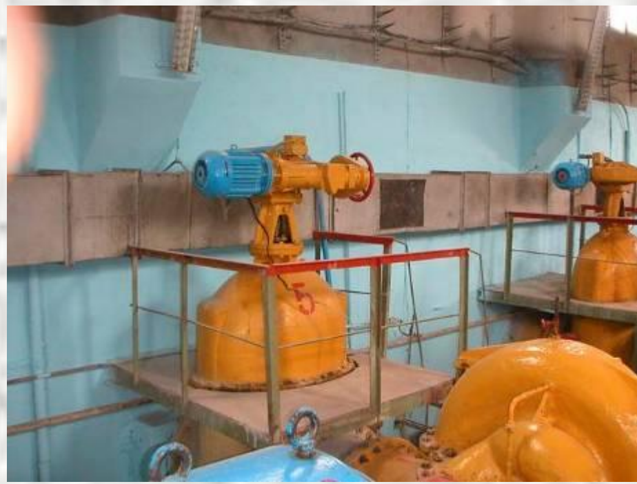
...после проведения работ
