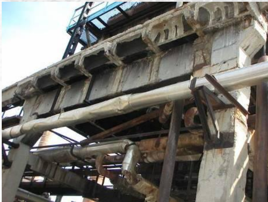
...до проведения работ
