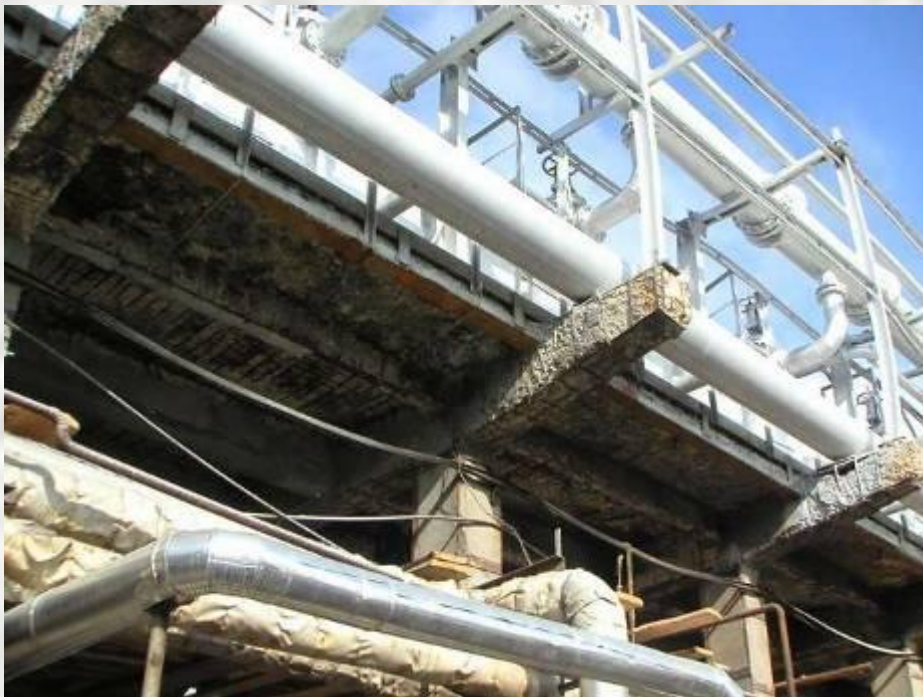
...до проведения работ
