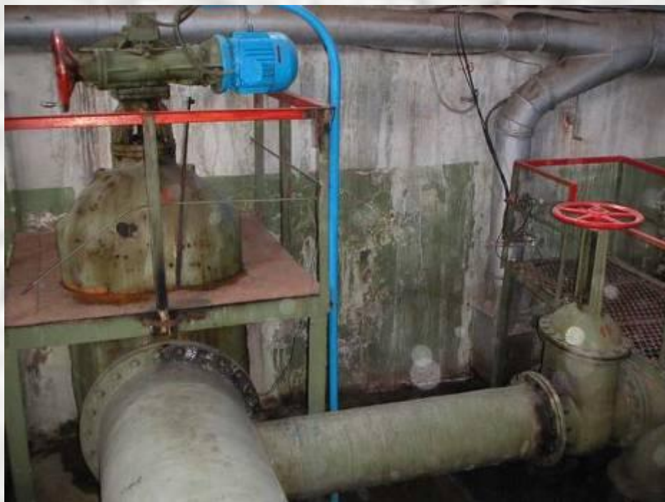
...до проведения работ
