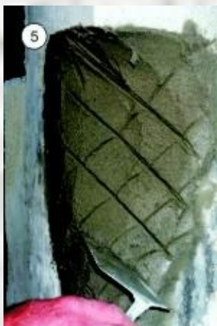
Подготовка под основания под восстановление бетона
