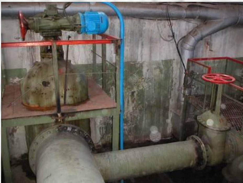
...до проведения работ
