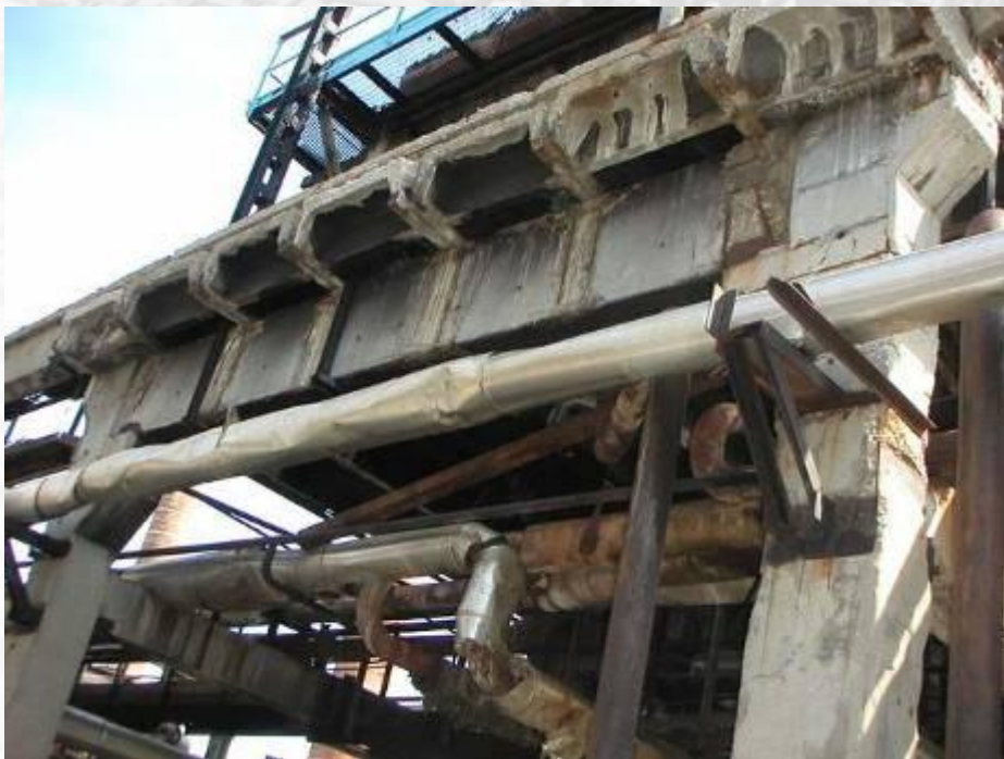
...до проведения работ
