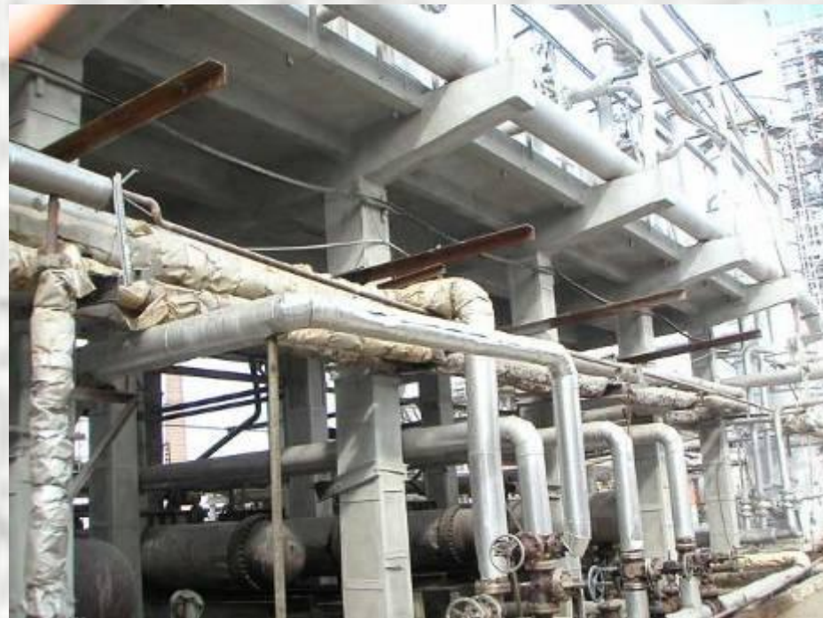
...после проведения работ
