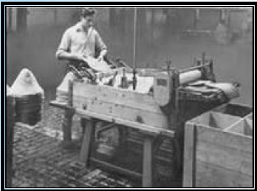
В середине 19, начале 20 веков изобрели валяльные прессы, и валяльные машины. Валка происходила посредством сдавливания и прокатывания шерсти или при механическом воздействии специальных иглок, которые спутывали шерстяные волокна.
