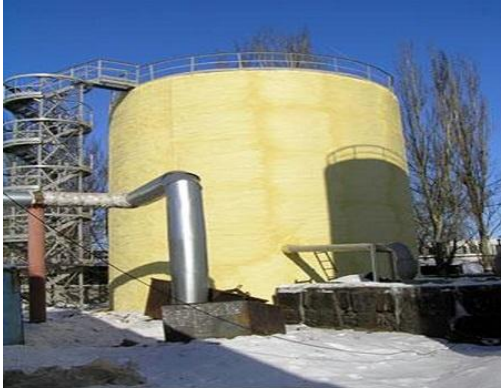
Теплоизоляция емкостей
