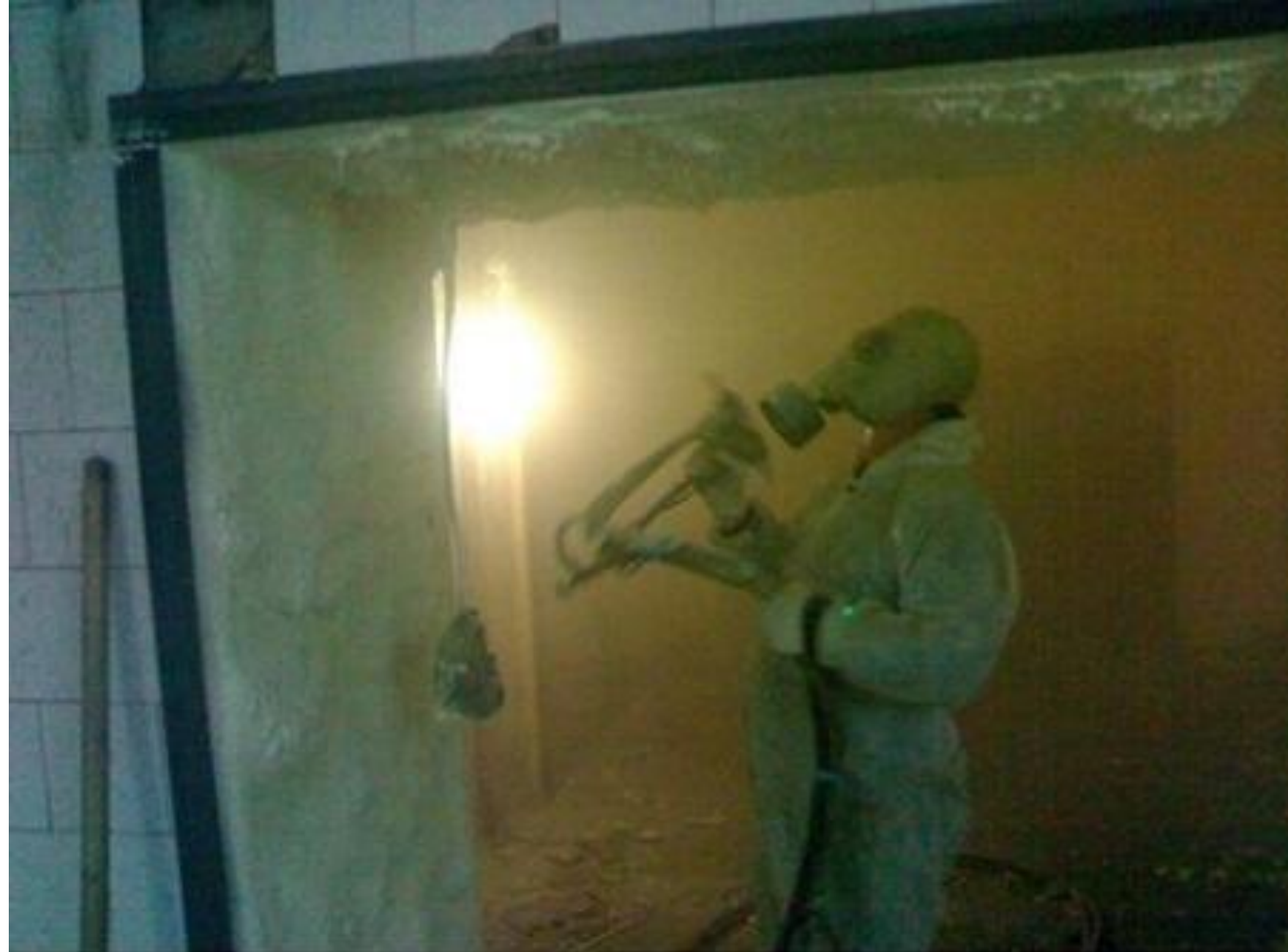
Внутреннее утепление склада
