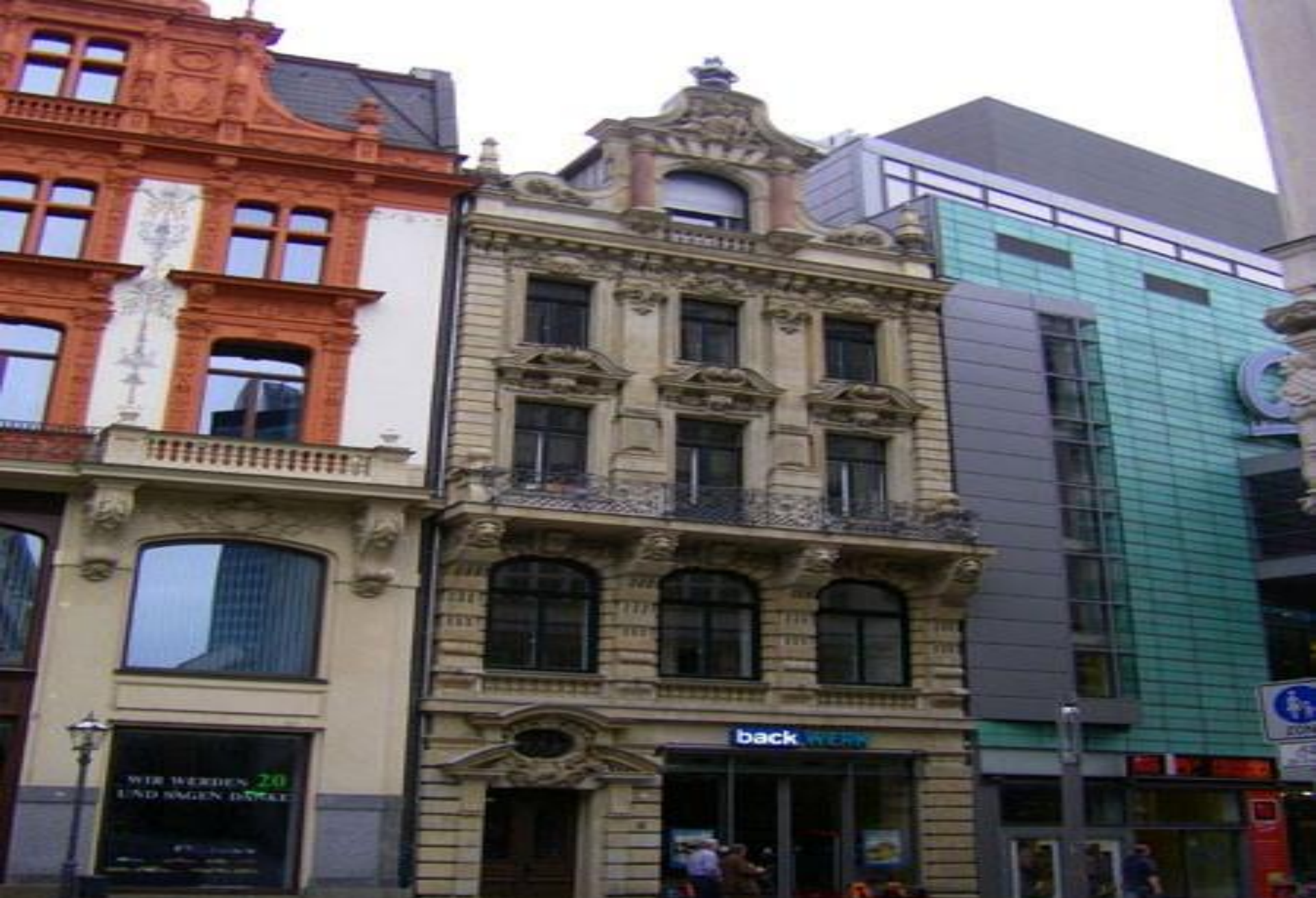
дом Клингера / Klingerhaus (Petersstrasse, 48), построенный в 1887-1888 г.г.
