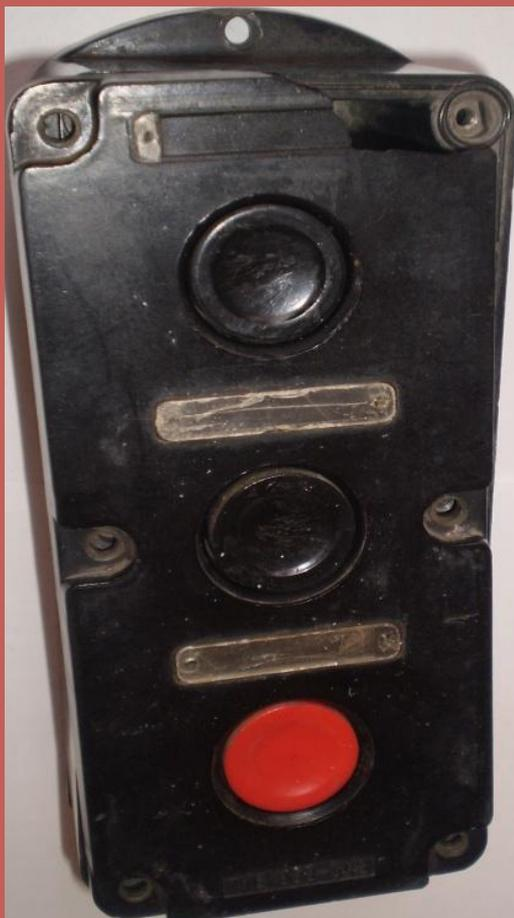
*Для ручного включения и выключения электродвигателей через магнитные пускатели или контакторы служат кнопочные станции .*
