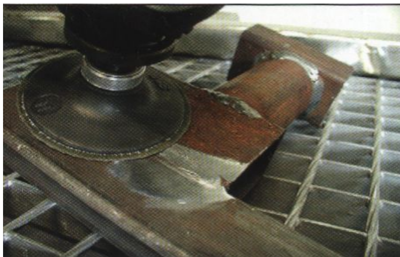
Удаление сварного шва
