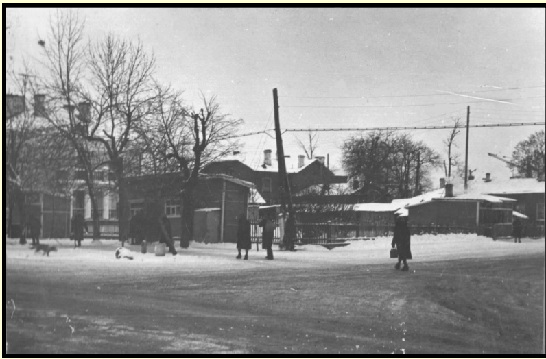
Территория будущей стройки
