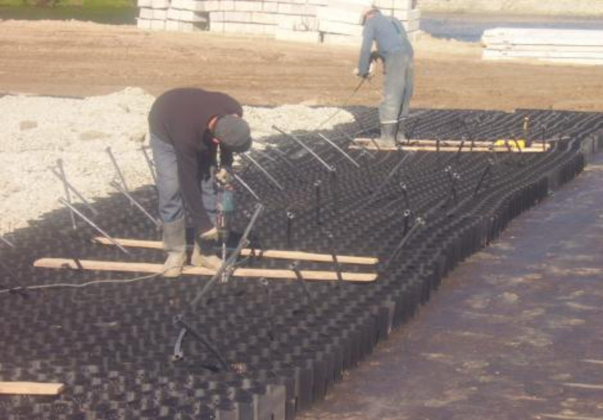
крепление пространственной решётки
