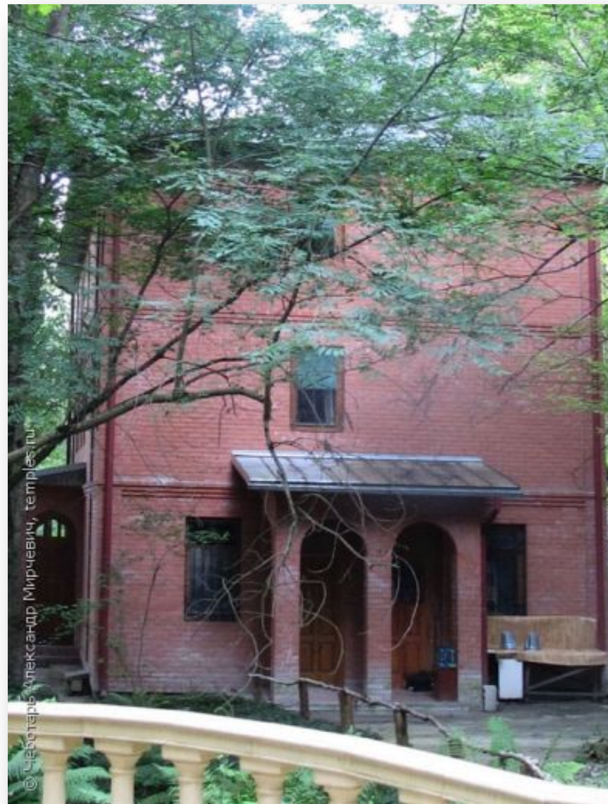
Западный фасад сестринского корпуса пустыни Феодосия Кавказского
