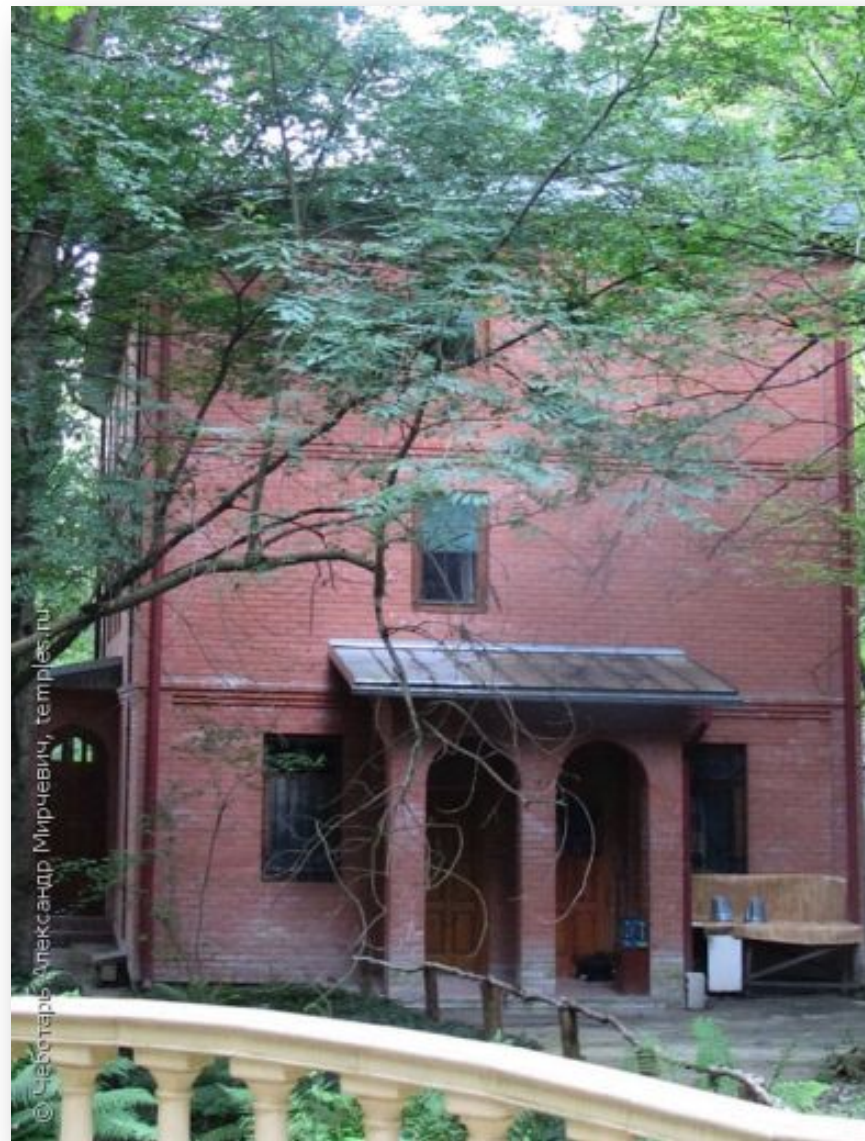
Западный фасад сестринского корпуса пустыни Феодосия Кавказского
