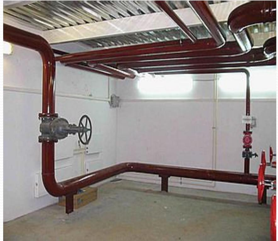
Узел управления. Ввод трубопровода из производственного цеха.
