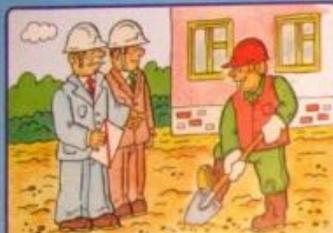
Земляными работами в зоне действующих подземных коммуникаций должен руководить непосредственно инженерно-технический работник. В охранной зоне кабеля под напряжением или газопровода, кроме того, работник электро- или газового хозяйства
