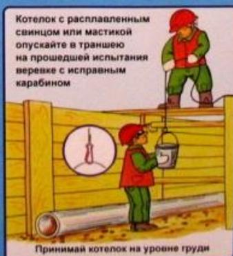
Котелок с расплавленным свинцом или мастикой опускайте в траншею на прошедшей испытанию веревке с исправным карабином
