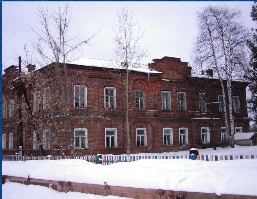
Здание земской больницы
