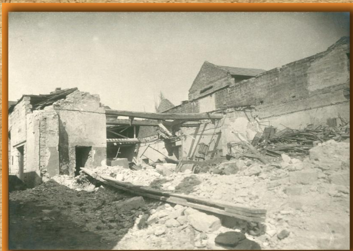
Ставропольский хлебокомбинат, разрушенный в период немецко-фашистской оккупации. 20 марта 1943 года
