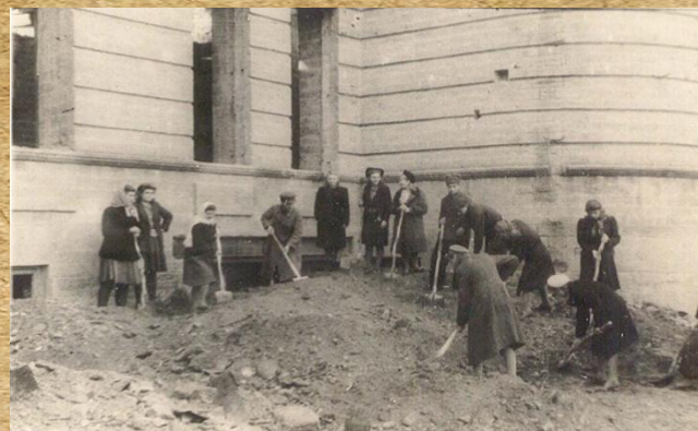
Один из разрушенных корпусов института г. Ставрополь
