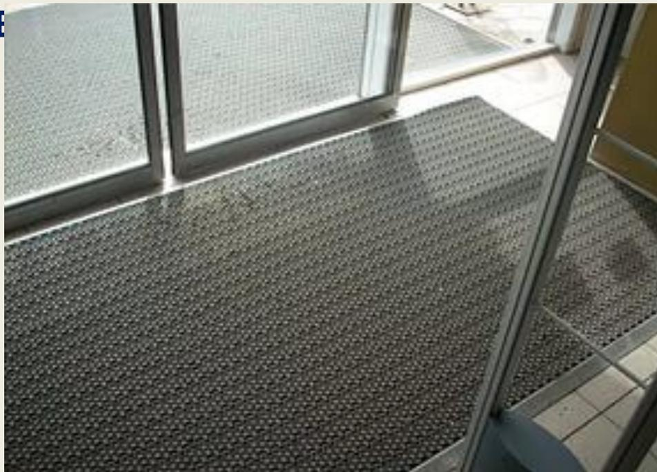
Покрытие собирает с обуви грязь, песок, крупнозернистые твердые частицы и поглощает влагу, сохраняя при этом опрятный внешний вид. Крупные комки грязи проваливаются в ячейки между алюминиевыми ламелями, которые расположены на расстоянии 4-8 мм друг от друга
