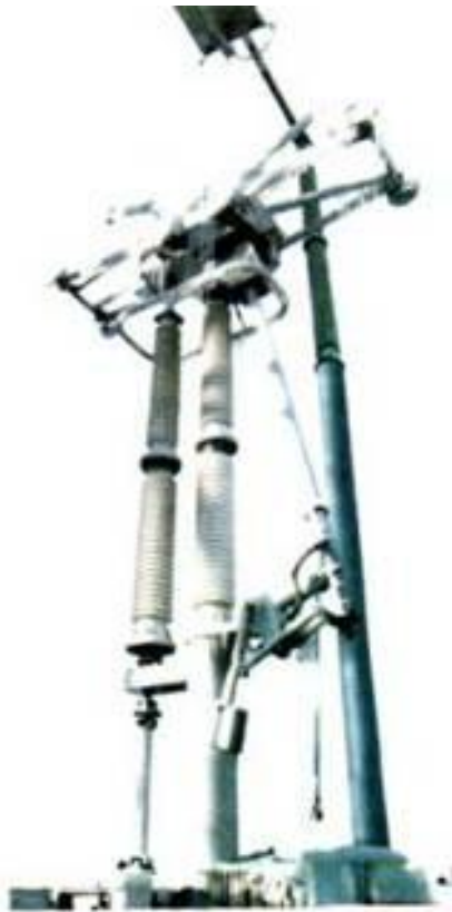
Разъединители пантографного типа РПВ U_{ном} = 330-500 кВ I_{ном} = 3150 А
