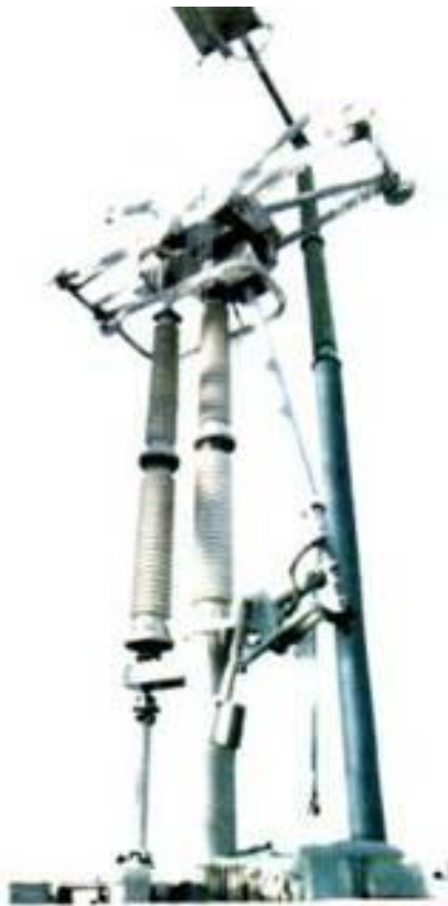
Разъединители пантографного типа РПВ U_{ном} = 330-500 \text{ кВ} I_{ном} = 3150 \text{ А}
