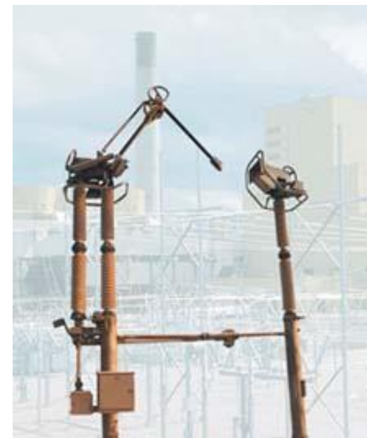
Разъединители полу-пантографного типа РПГ U_{ном} = 330-750 \text{ кВ} I_{ном} = 3150 \text{ А}
