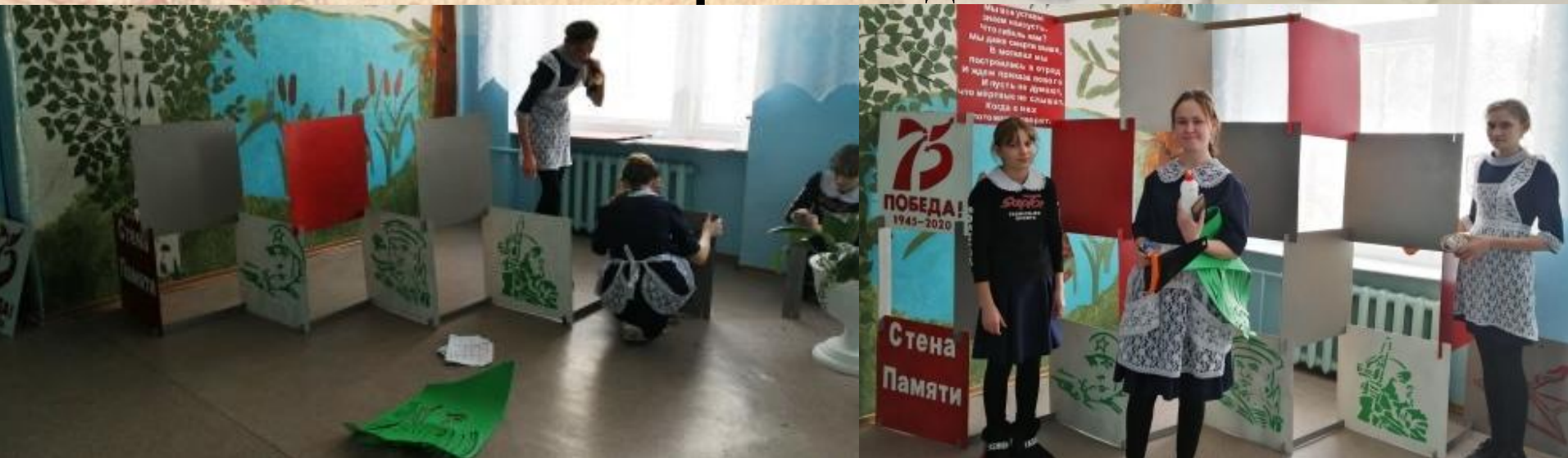
Рис. 27. Сборка стенда производилась поэтапно, с применением дополнительных опор
