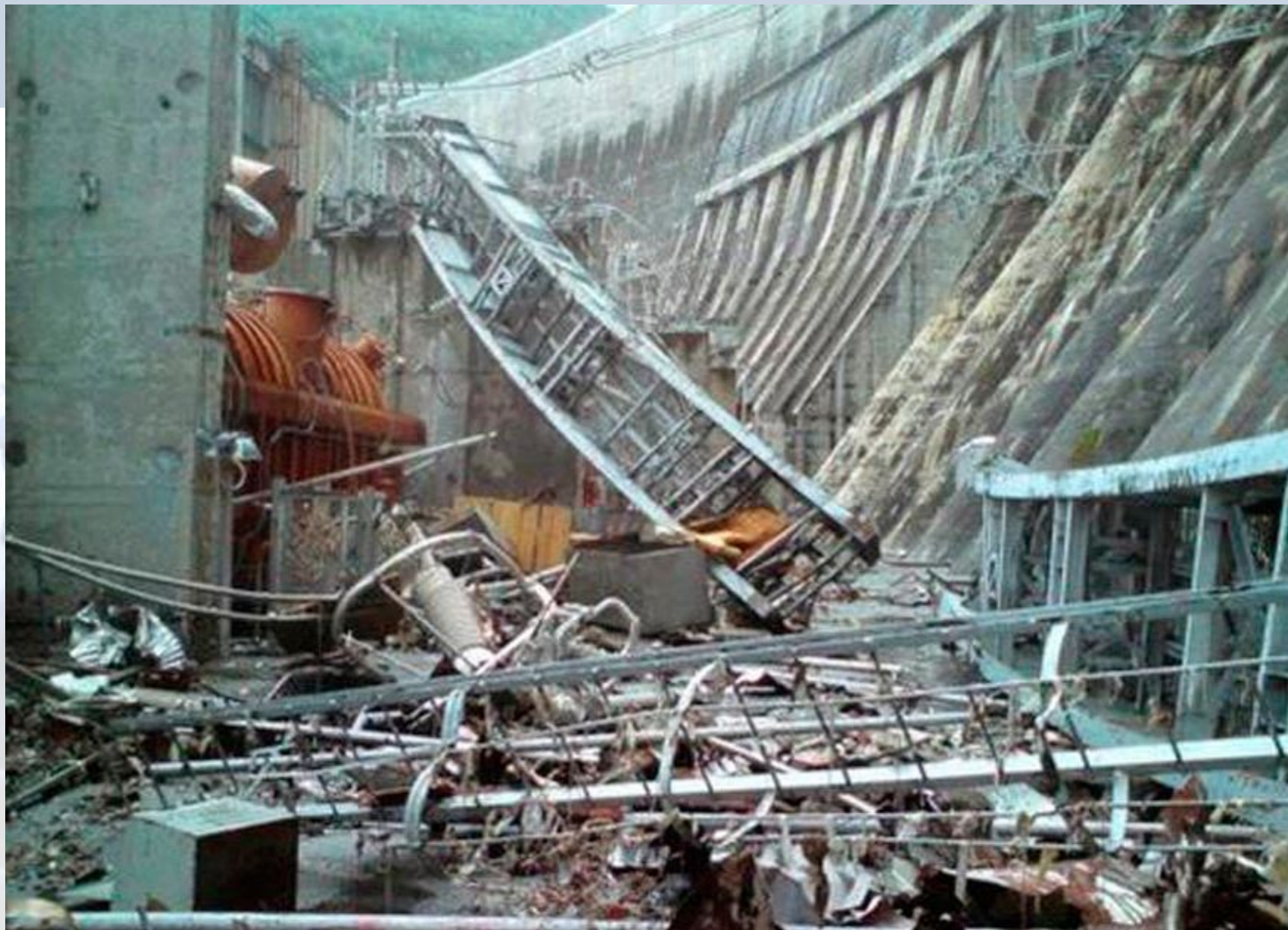
Последствия катастрофы на Саяно-Шушенской ГЭС, август 2009 г.
