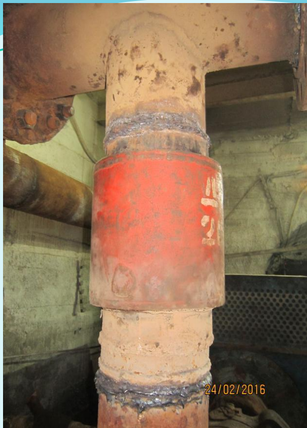
обратный клапан Д 200/64 горизонта – 90 м
