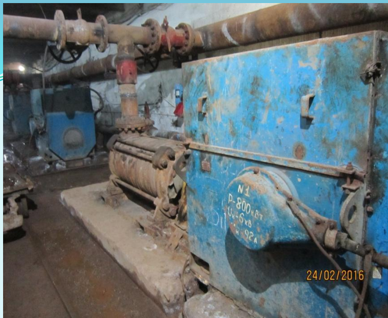
насос ЦНС 300/600 с двигателем горизонта – 90 м
