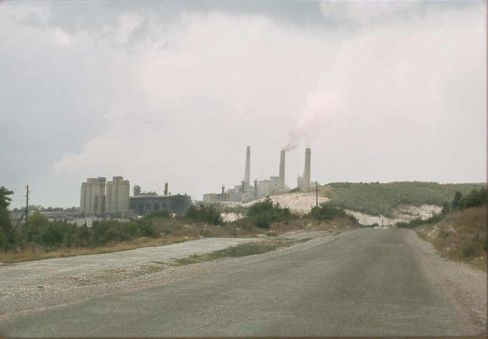
1964 год Цементный завод в Тоннельной
