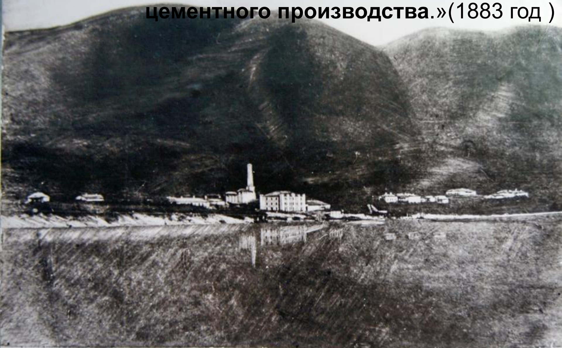
Заводъ Общ. Черноморскаго Цементнаго Пр-ва въ 1883г.
