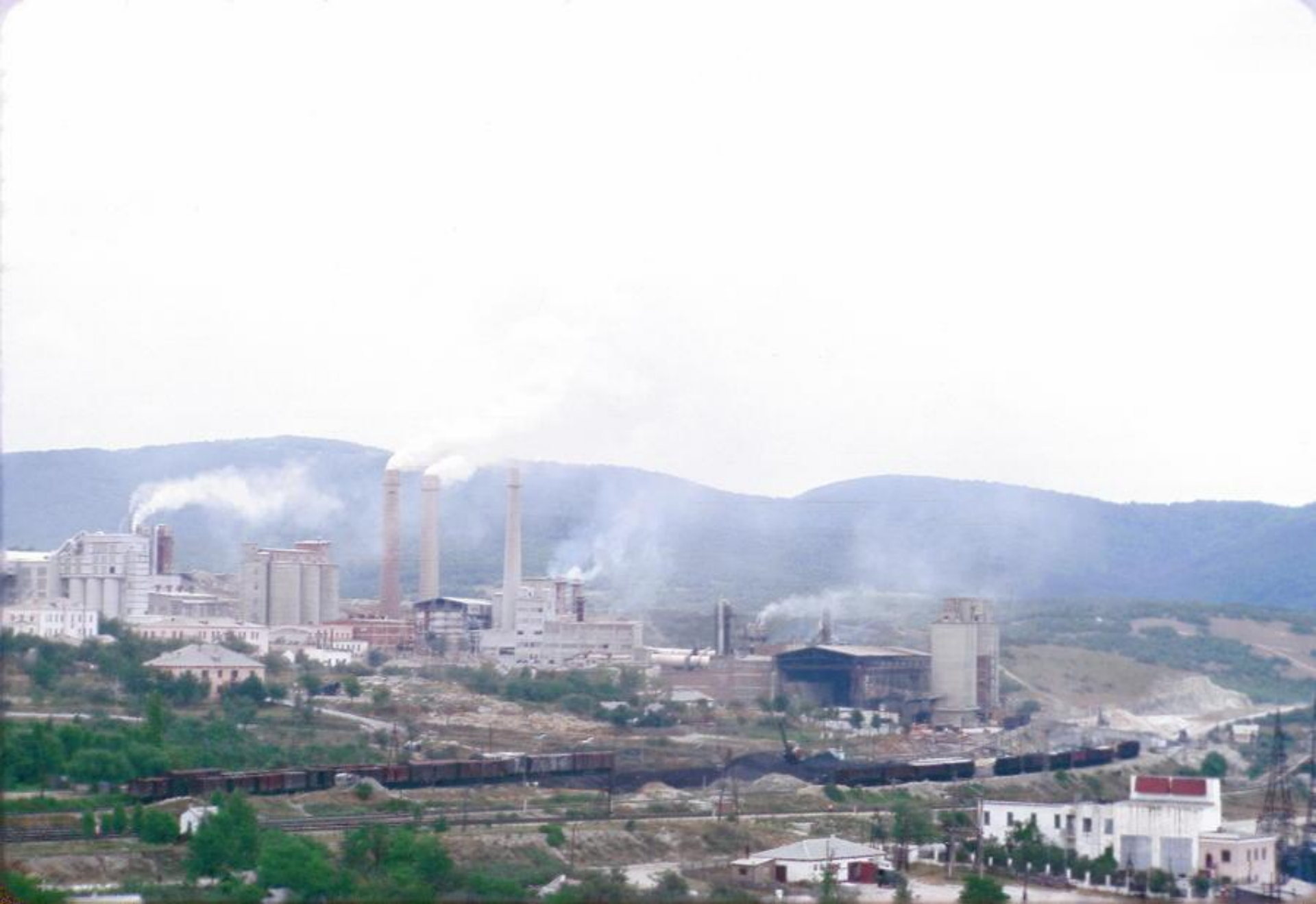
1964 год Цементный завод в Тоннельной
