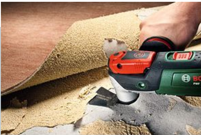
Удаление остатков ковровых покрытий
