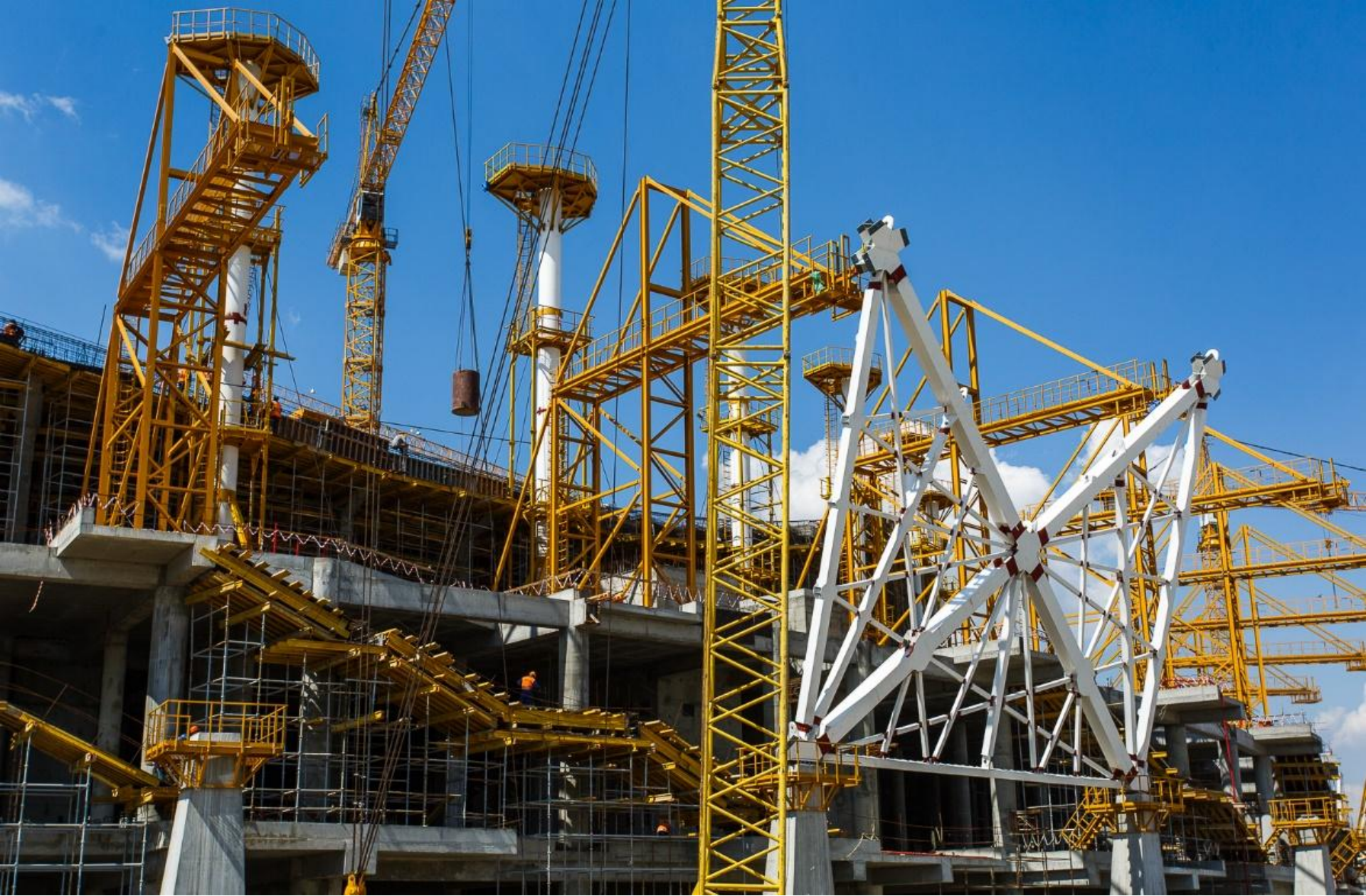
Демонтаж старой арены Волгограда
