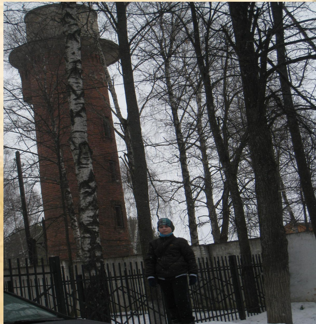
Водонасосная башня сейчас
