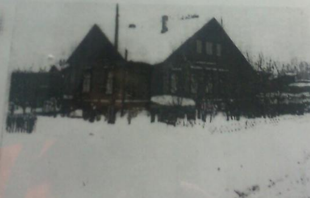
Казарма станции Саркуз
