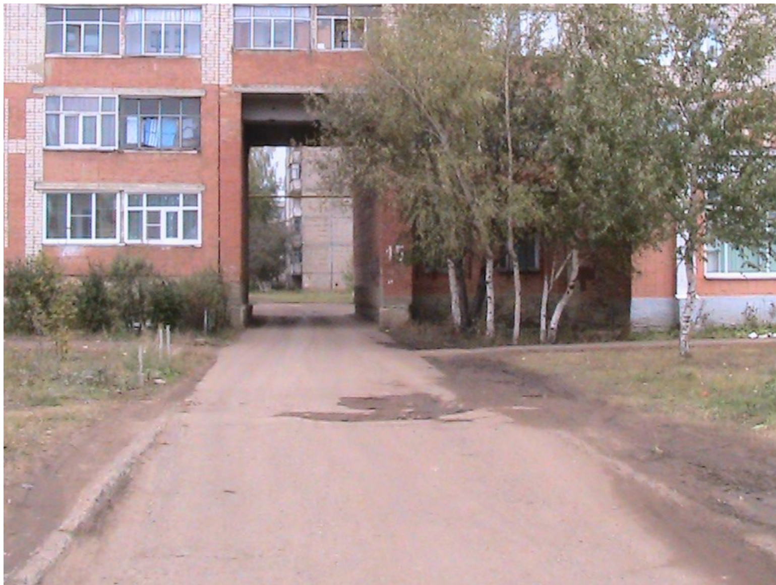
Междомовая арка по адресу: г. Рузаевка, ул. Юрасова д.15
