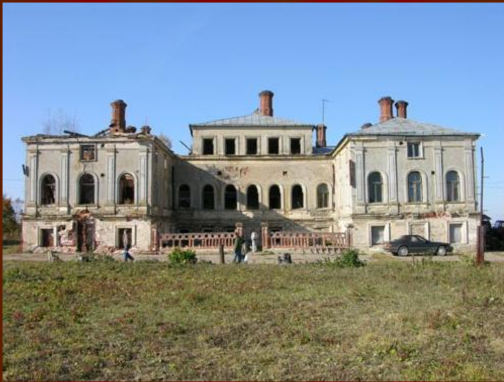
3.Главный дом. Южный (дворовый) фасад
