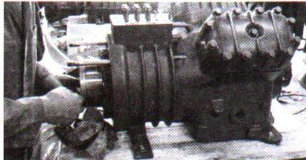
Снятые крышки, ротор и статор укладываются отдельно. Затем снимаются крышки цилиндров и вынимаются клапанные доски, которые при необходимости могут разбираться.
