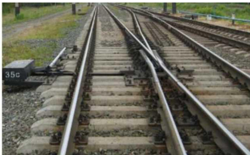
Стрелочный перевод с подвижным сердечником крестовины
