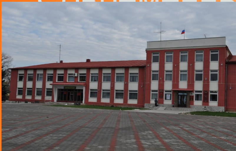
Здание районной администрации
