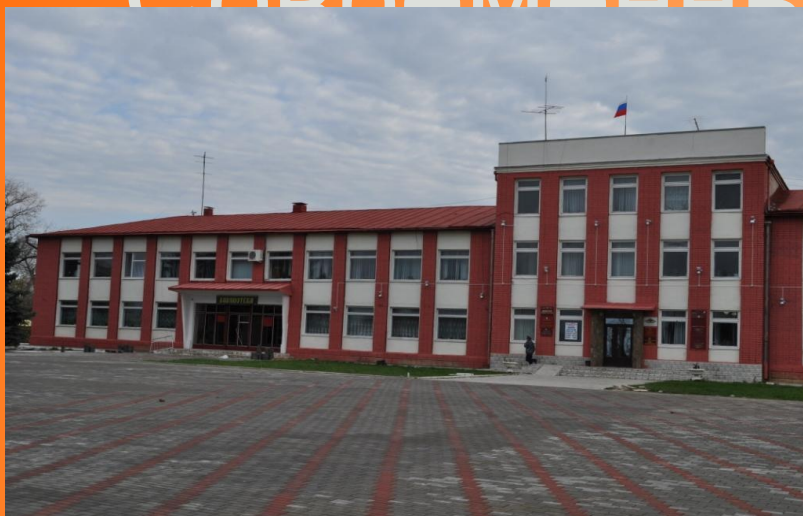
Здание районной администрации
