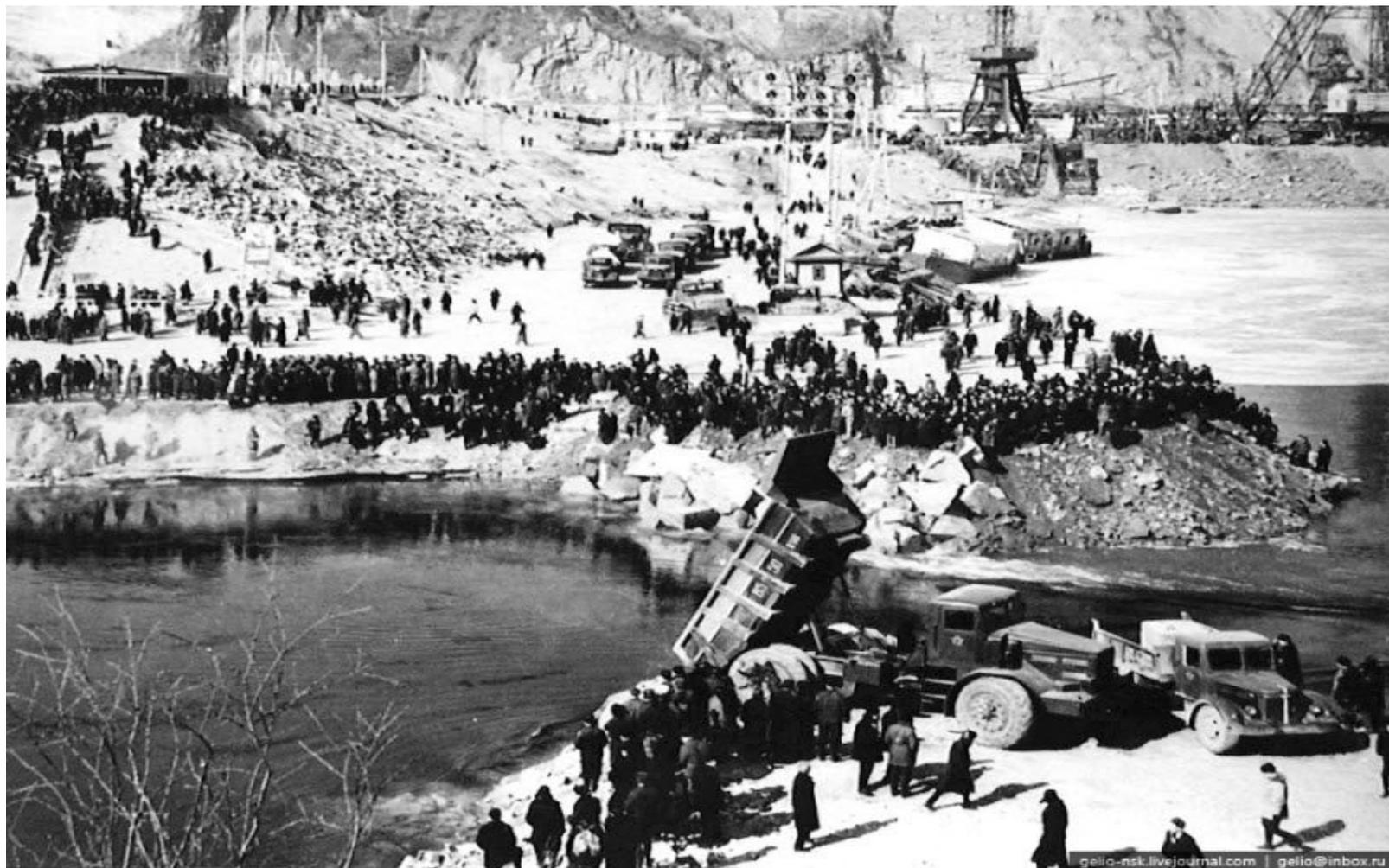
Всего при строительстве тела плотины было уложено 5,7 млн м<sup>3</sup> бетона.
