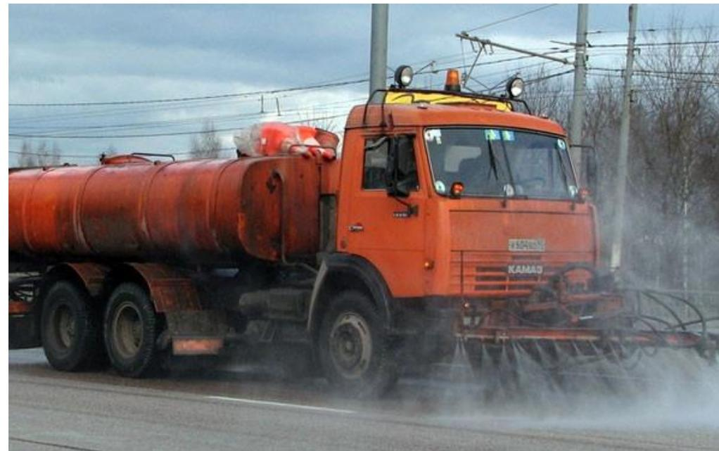
Для обеспечения нормальных условий движения в жаркое и сухое время года на пылящих покрытиях проезжей части и неукрепленных обочинах, особенно в населенных пунктах, у автобусных остановок и т.п., проводят работы по обеспыливанию.
