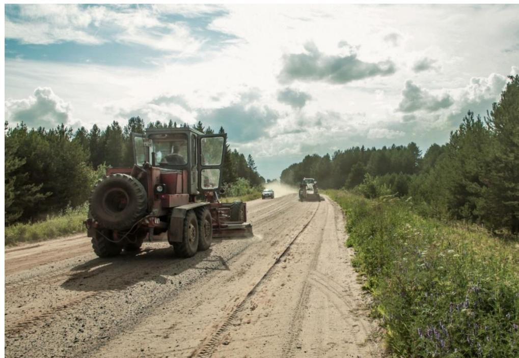
На дорогах с переходными и низшими типами дорожных одежд с целью улучшения ровности покрытия (после дождей в весенний и осенний периоды) осуществляют профилирование покрытия
