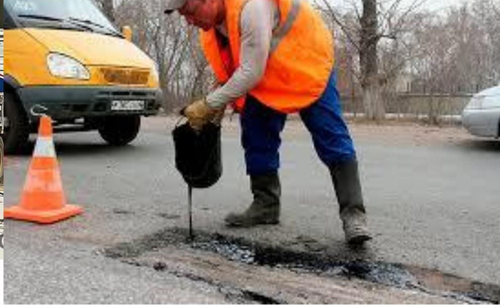
3. Способ "обратной пропитки" предусматривает (после проведения подготовительных работ традиционным методом) заливку выбоины вязким, нагретым до  $160^{\circ}\text{C}$ , битумом и подачу в нее необработанного щебня естественной влажности. При соприкосновении холодного влажного щебня с горячим битумом происходит пенообразование последнего с обволакиванием щебня. Уплотнение ручной мототрамбовкой.
