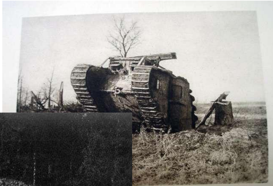
lichten Laufbänder zu sehen, mit deren Hilfe sich das Umgebende fort- wärts, mächtige mit zwei Geschützen und zwei Maschinengewehren und Die Panzerung ist 8-13 mm stark, die Geschwindigkeit beträgt 6 km Std.
