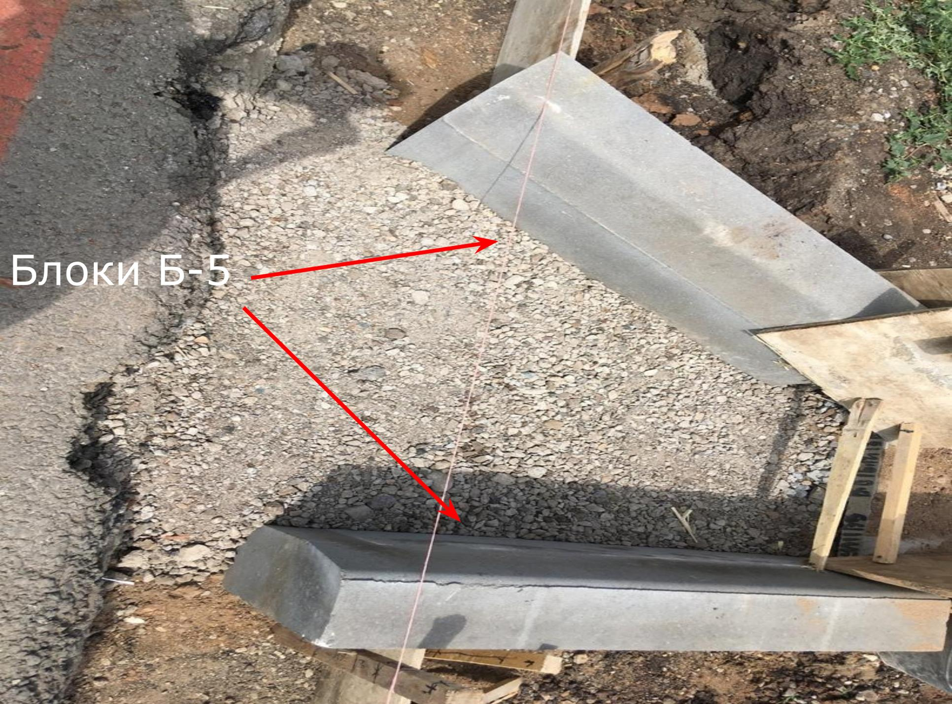
Сборная конструкция системы отвода воды из телескопических лотков Б-6
