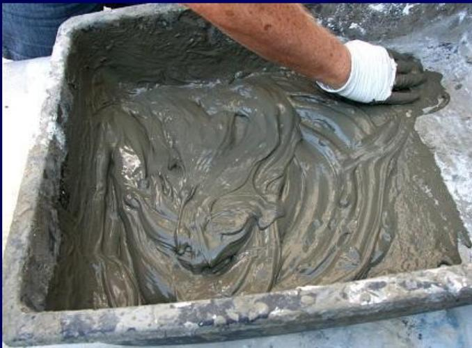
**Для оштукатуривания наружных поверхностей - кирпичных, бетонных и каменных стен - применяются известковые, цементно-известковые или цементно-глиняный растворы.**
