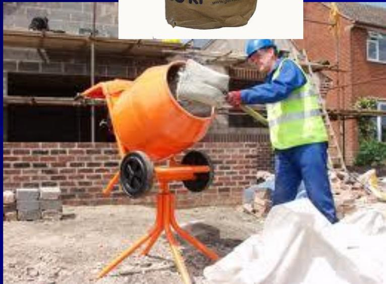
Для оштукатуривания бетонных или кирпичных стен - лучше использовать известковые, известково-глиняные, известково-глино-гипсовые, известково-гипсовые или цементно-известковые растворы, для обработки деревянных поверхностей раствор, в состав которого входит гипс - он отличается повышенной прочностью.
