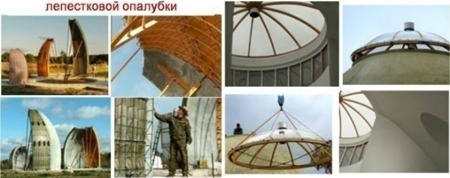
Примеры использования лепестковой опалубки
