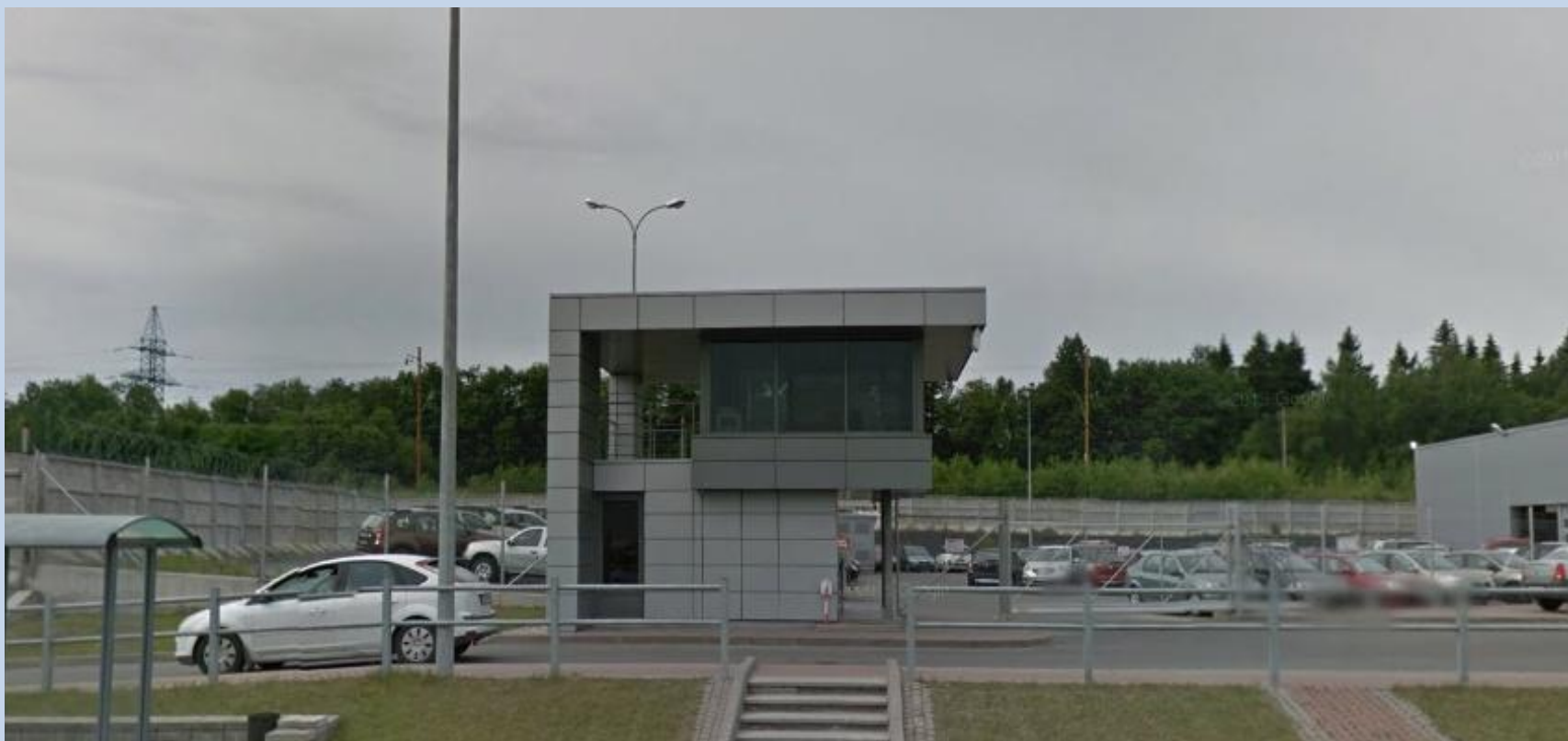
Пост охраны, зона хранения техники
