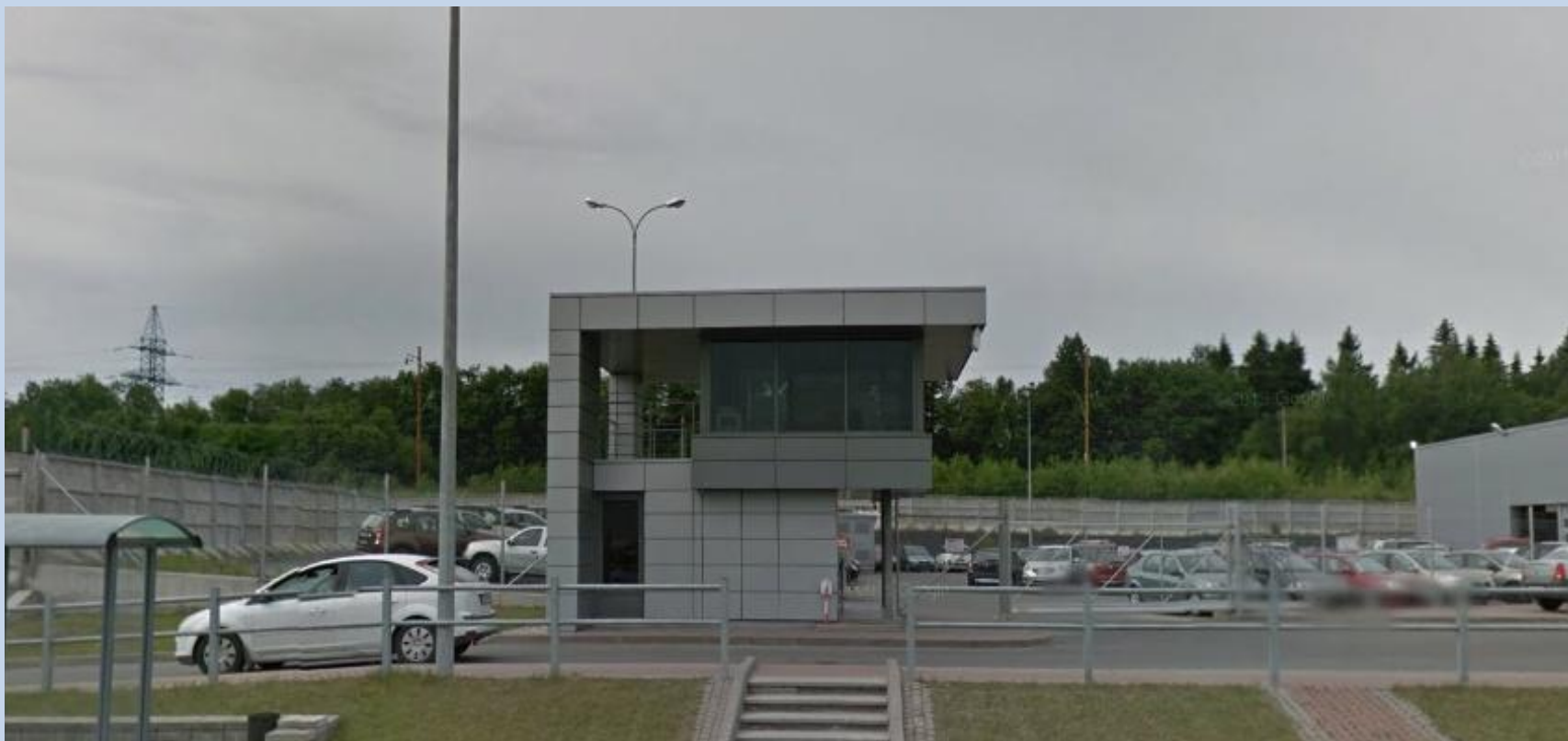
Пост охраны, зона хранения техники
