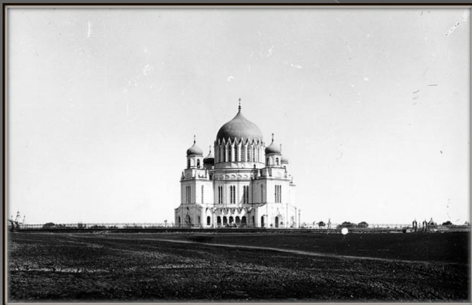
Александро-Невский собор в Вятке. Вид с юго-западной стороны. Фото нач. XX века.
