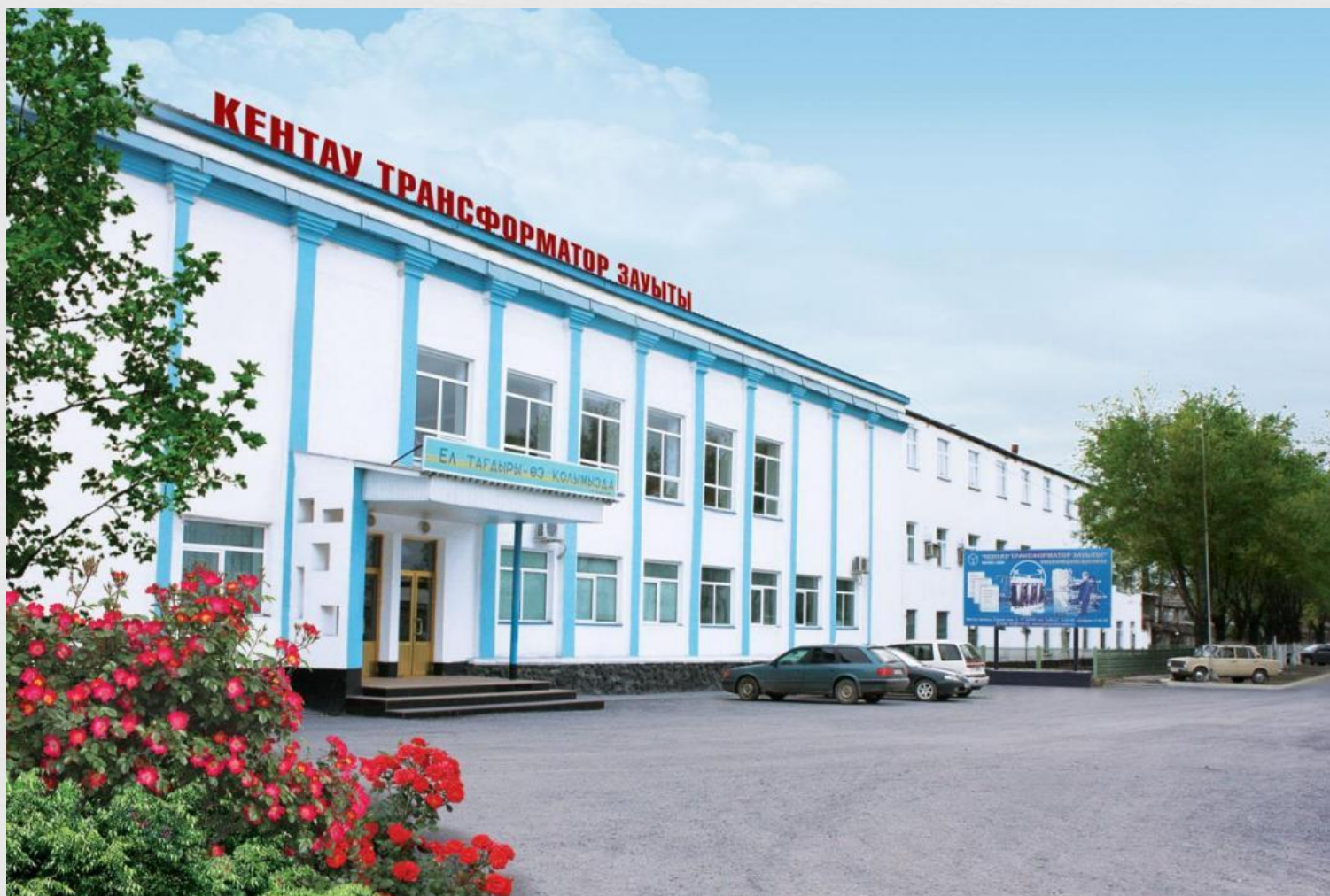
Кентау трансформатор зауыты
