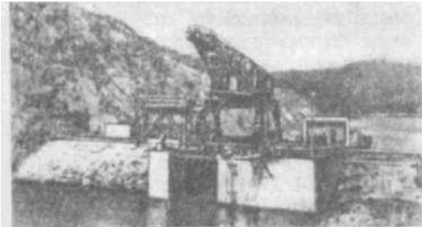
Кислогубська припливна електростанція.
