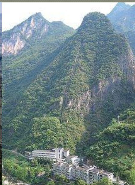
малая ГЭС Хоуцзыбао, Китай
