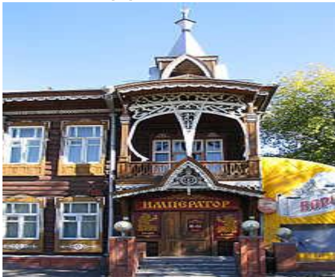
Дом купцов Шадриных, пр. Красноармейский, 8
