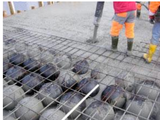
С использованием опалубки «sobiax»
