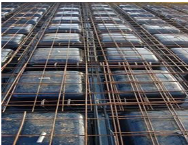
С использованием опалубки «skydome»
