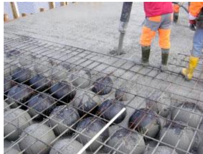
С использованием опалубки «sobiax»
