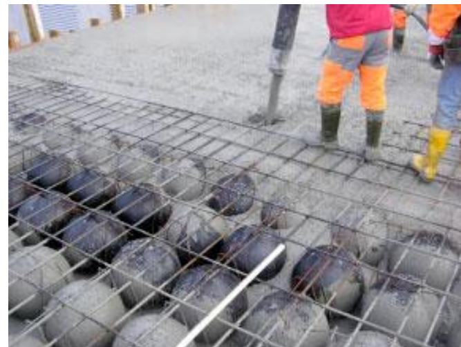
С использованием опалубки «sobiax»
