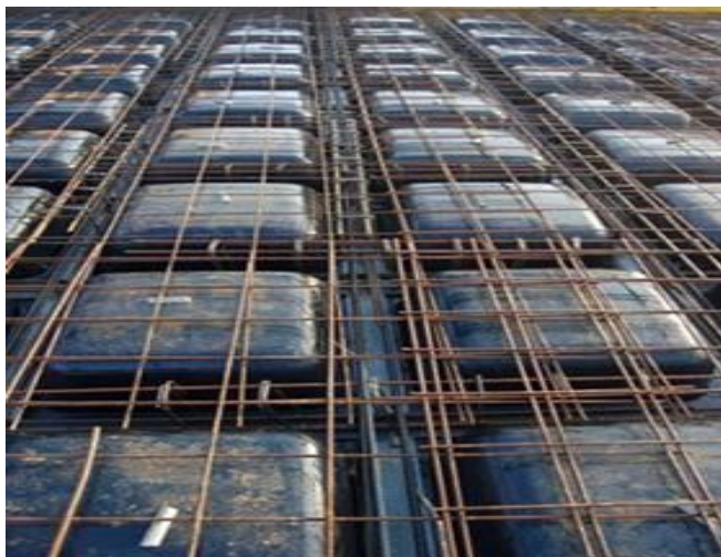
С использованием опалубки «skydome»
