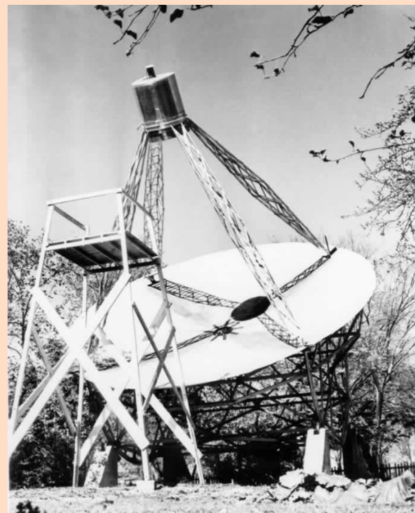
Меридианный радиотелескоп Гроута Ребера (1937-1939 г.)
