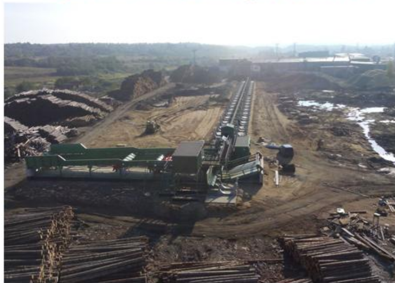
Монтаж линии сортировки пиловочника Nekotek
