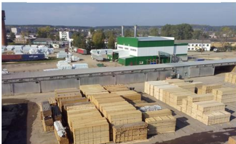
Котельная Agro и сушильные камеры
