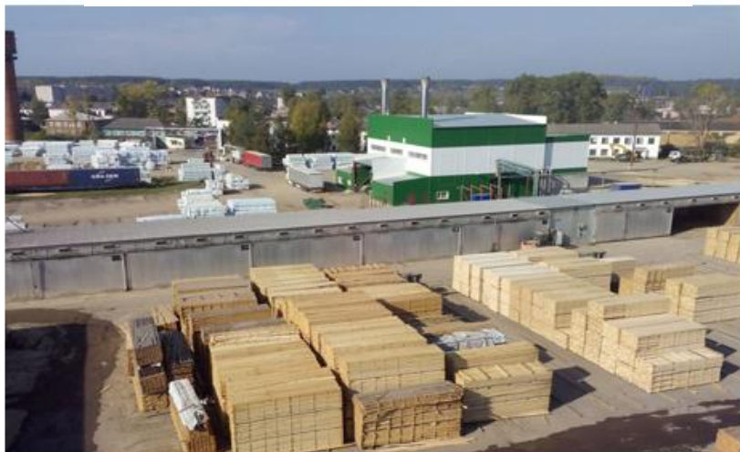
Котельная Agro и сушильные камеры
